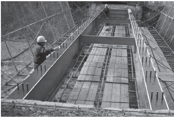
写真 - 6 スタッドジベル溶殖およびソールスポンジ設置状況
