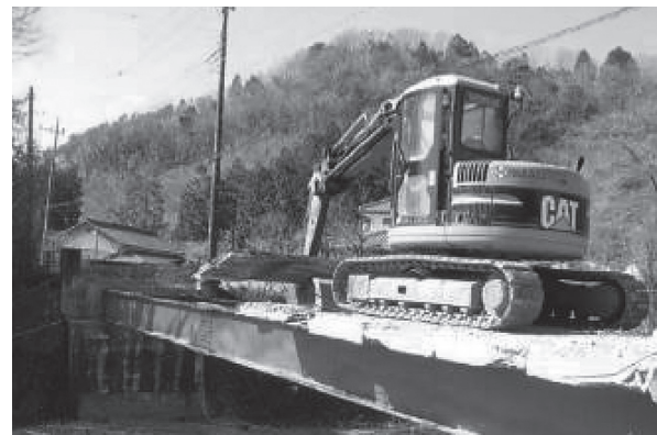
写真 - 5 既設床版撤去状況
