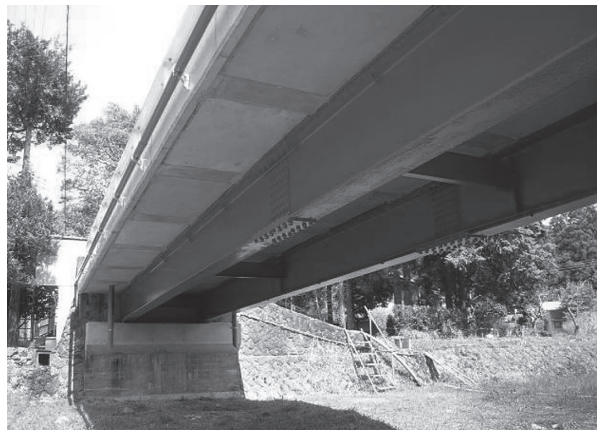
写真 - 10 完成 (橋梁下面から)
