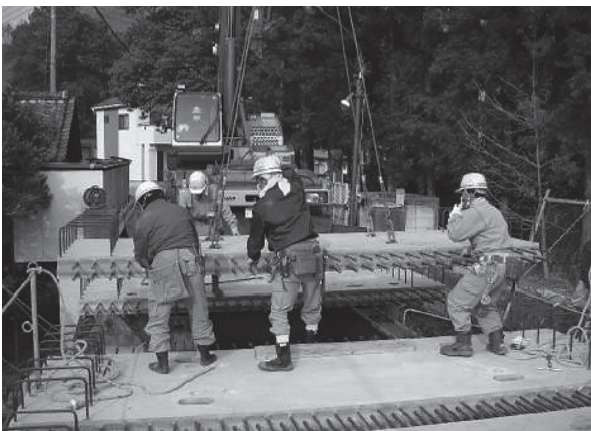
写真 - 7 SLJ スラブの架設状況
