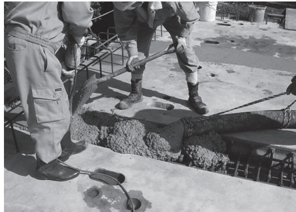
写真 - 9 接合部のコンクリート打設状況
