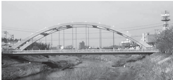
写真 - 1 橋梁全景
