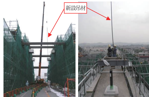
写真-4 PC鋼材設置状況
