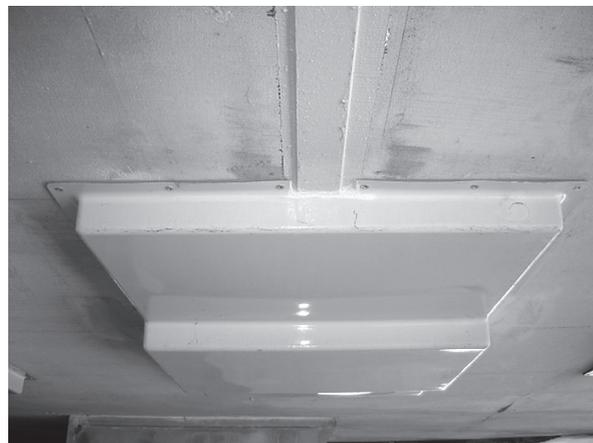
写真 - 15 定着体保護カバー 近接目視点検
