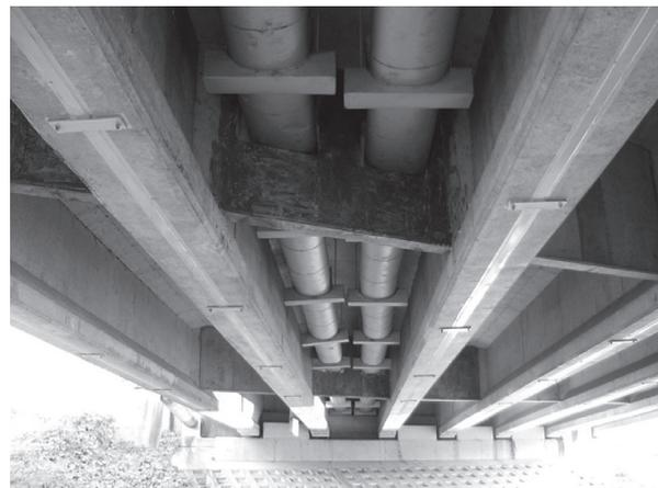
写真 - 4 桁間添架物と緊張材の配置
