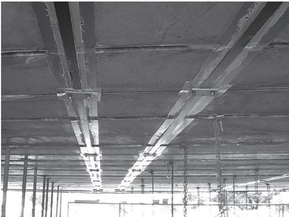
写真 - 10 主桁下面 中間定着体配置
