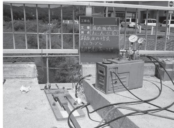
写真 - 7 主桁上面 緊張材配置 (1 本配置)
