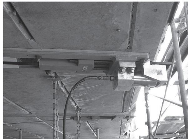
写真 - 8 主桁下面 緊張材配置 (1 本配置)
