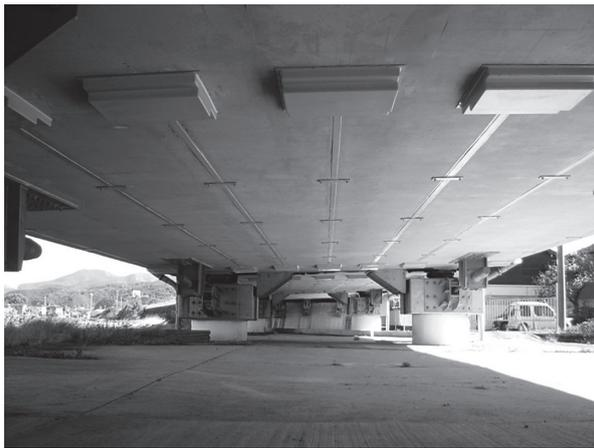
写真 - 6 中空床版橋補強状況
