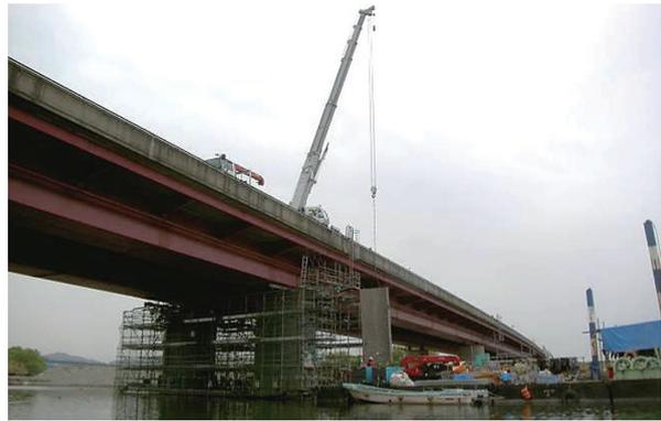
写真 - 3 PCa パネル架設状況
