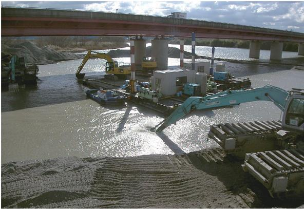
写真 - 2 河床掘削状況
