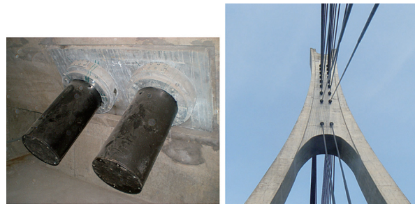
写真 - 5 主桁内斜材定着部 写真 - 6 主塔斜材定着部
