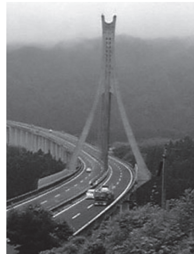
写真 - 1 碓氷橋全景
