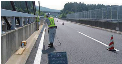
写真 - 2 たわみ測定状況
