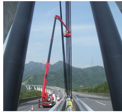
写真 - 3 斜材ケーブルの張力測定状況
