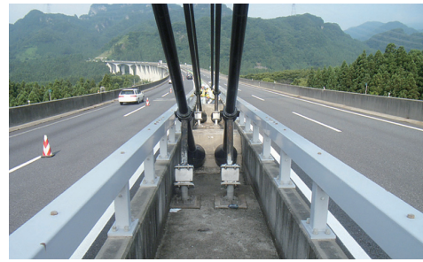
写真 - 4 緩衝装置・ダンパー
