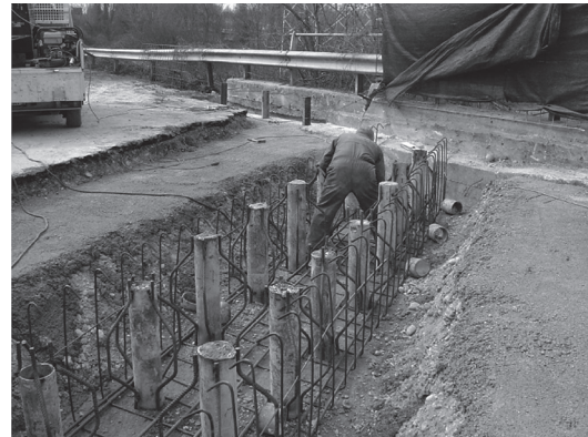
図-5 新設された小径杭
