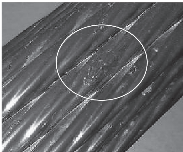
写真 - 4 補修済みの箇所 (B 橋の例)
