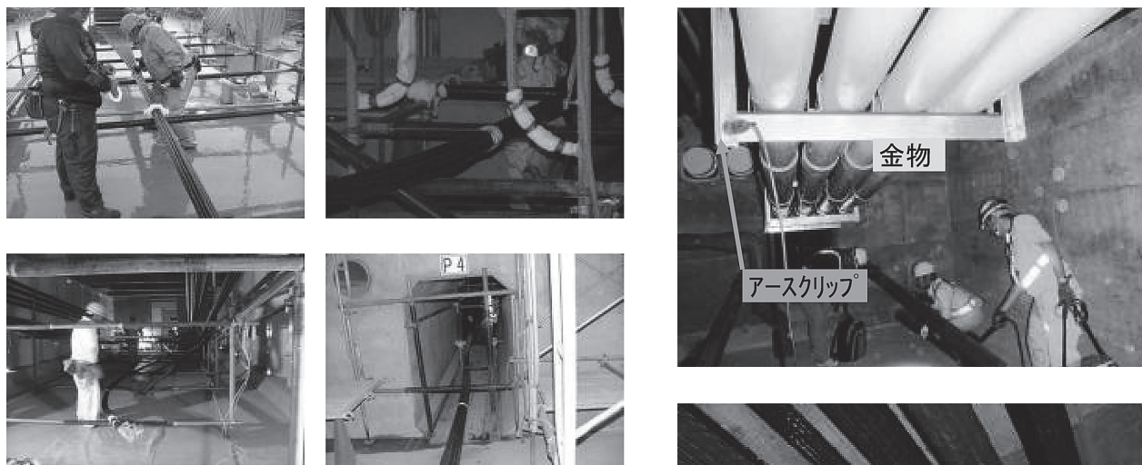
写真 - 1 模範的な施工状況 (B 橋)
