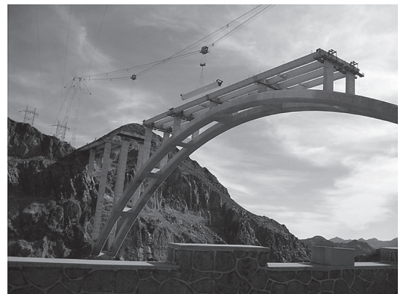
写真 - 10 上部工鋼製ガーダー架設状況
