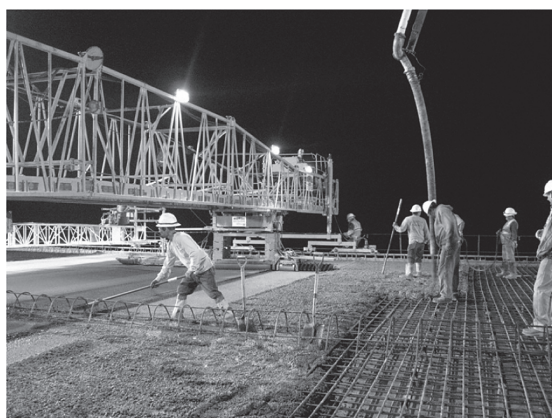
写真 - 11 床版コンクリート打設状況
