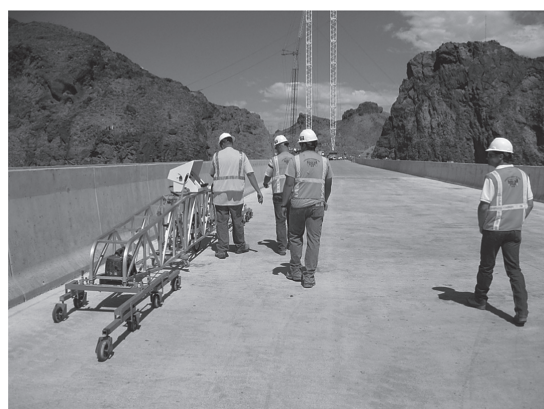
写真 - 12 床版コンクリート平坦性試験
