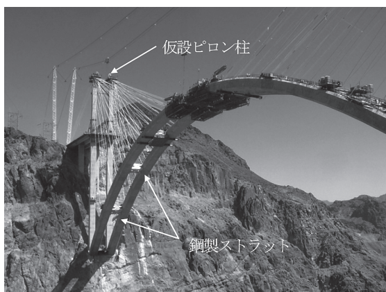
写真 - 4 アーチ架設状況
