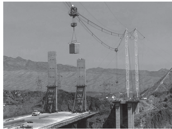
写真 - 3 ケーブルクレーン使用状況
