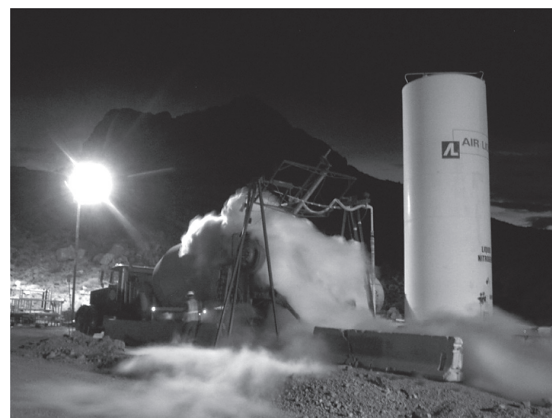
写真 - 6 液化窒素によるコンクリートの冷却
