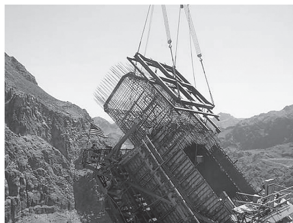
写真 - 5 鉄筋かご設置状況
