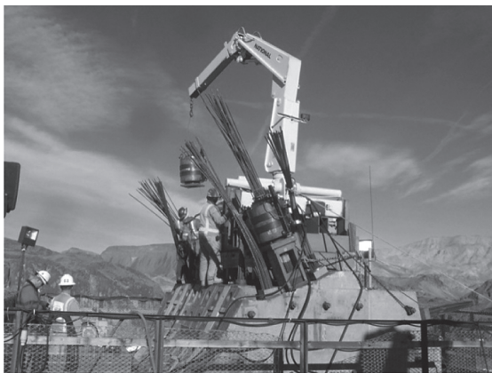
写真 - 7 斜材ケーブル緊張作業
