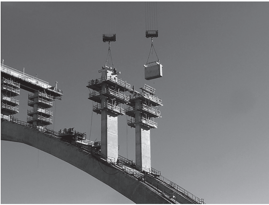
写真 - 9 橋脚プレキャストセグメント架設状況
