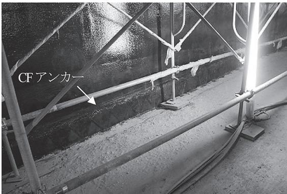
写真 - 12 CF アンカーの施工
