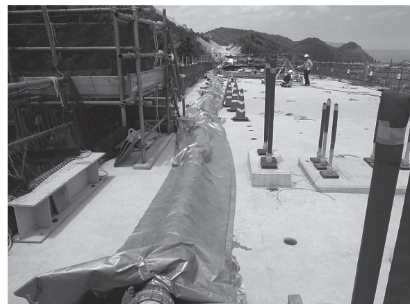
写真 - 2 水平配管への養生
