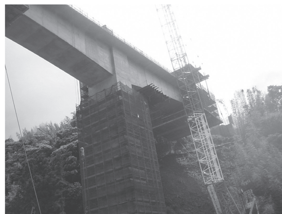
写真 - 11 P9 橋脚での張出し架設状況
