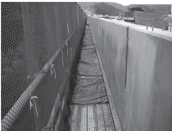
写真-14 高欄足場 ブルーシート敷設
