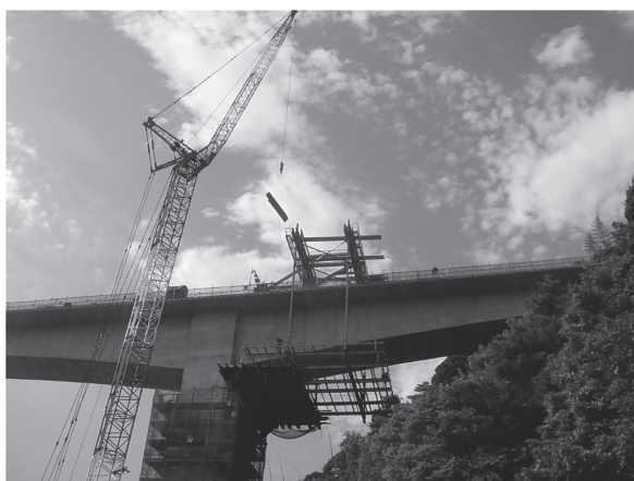
写真 - 10 P9 橋脚での移動作業車解体状況
