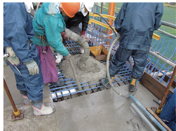
写真 - 9 拡幅部コンクリート打設状況
