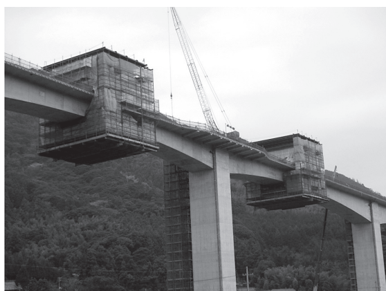
写真 - 4 移動作業車の寒中養生
