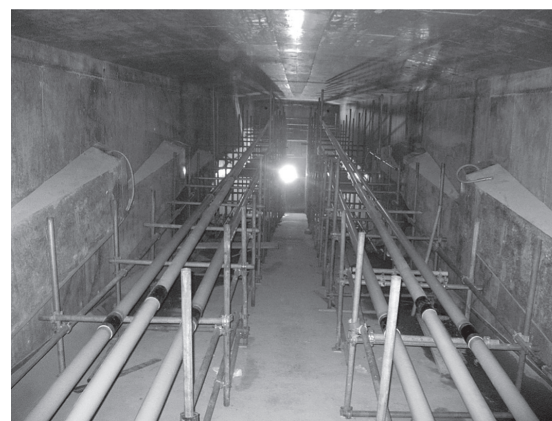
写真 - 12 外ケーブル架台の設置
