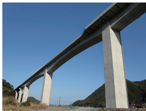
写真 - 20 全景写真（右から P7, P6, P5, P4 橋脚）
