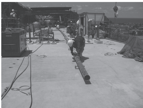
写真 - 3 水平配管移動の工夫
