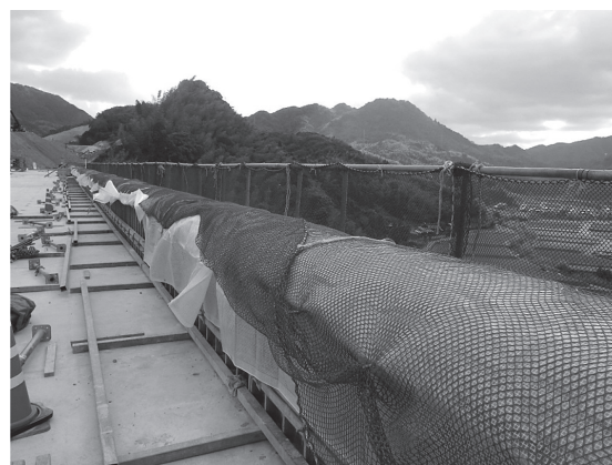
写真 - 6 壁高欄コンクリート打設後の養生
