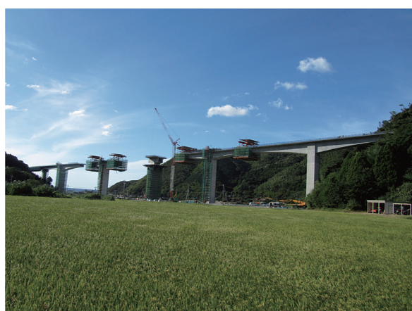
写真 - 18 施工中写真（平成 22 年 9 月撮影）
