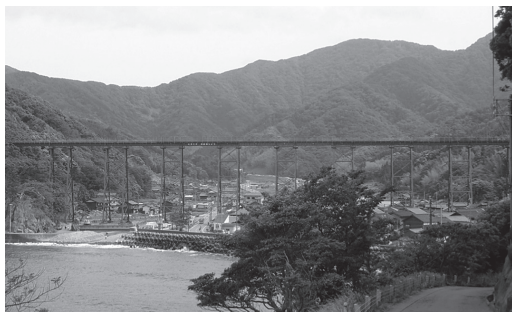
写真-1 余部橋量（旧橋）全景
