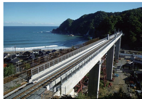
写真 - 6 余部橋りょう (新橋) 全景
