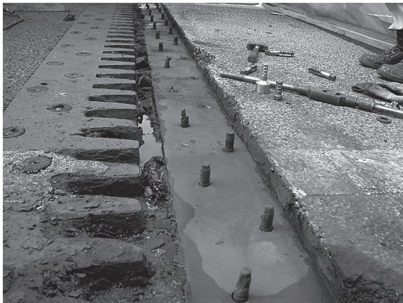
写真 - 7 フェイスプレート取付けボルトの破断状況
