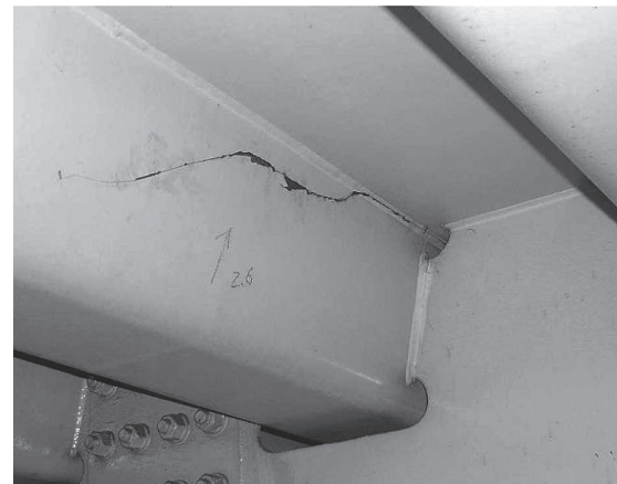
写真 - 6 輪荷重の繰返し荷荷による U リブの疲労亀裂
