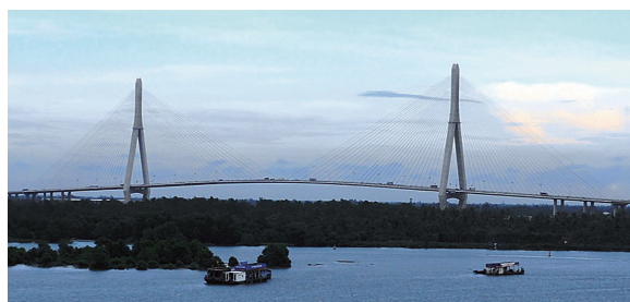
写真 - 1 カントー橋（斜張橋部）全景
