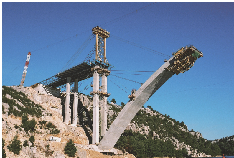
図 - 3 クルカ橋の張出し施工状況
