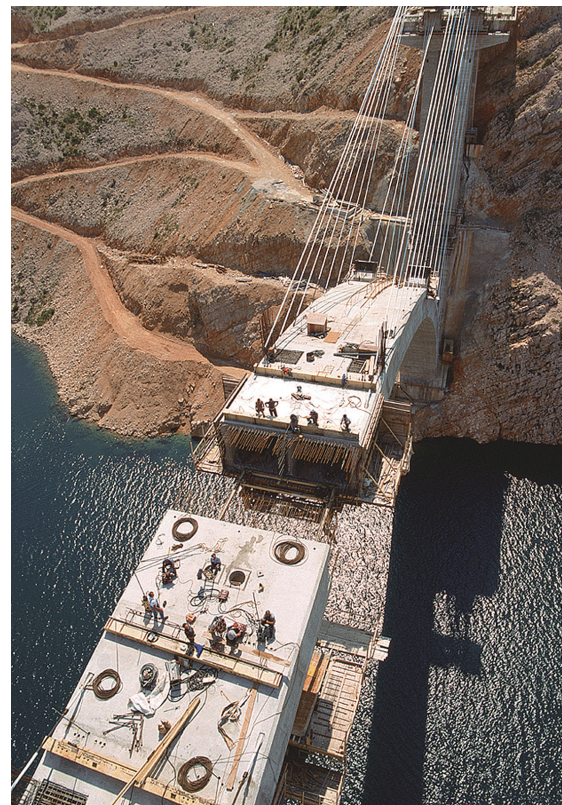
図 - 2 マスレニカ橋のアーチ部閉合状況
