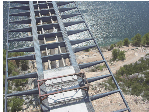
図 - 4 中間床版の設置
