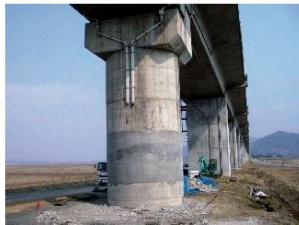
写真 - 2 橋脚の復旧状況
