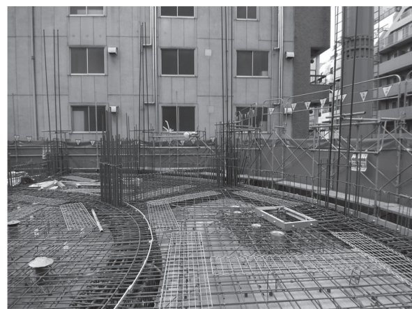
写真 - 9 PC鋼棒セット風景
