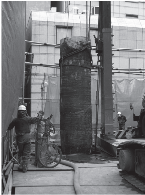
写真 - 6 既存杭引抜き工事風景
