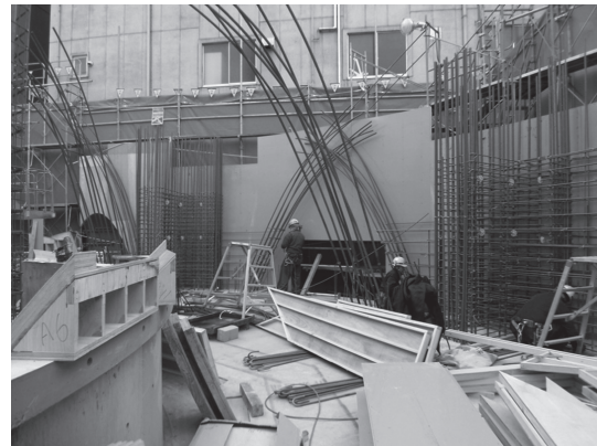
写真 - 7 アーチフレーム施工風景
