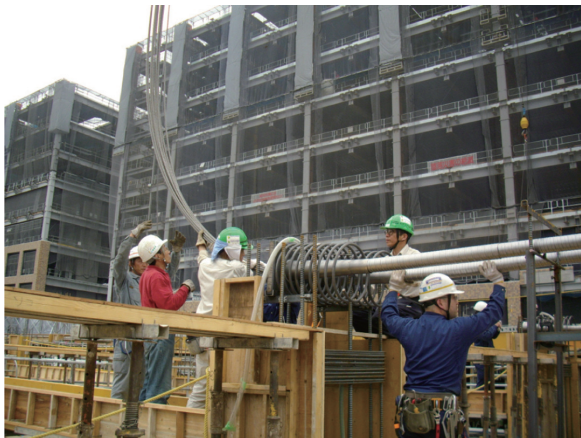
写真 - 6 PC 鋼線配線
