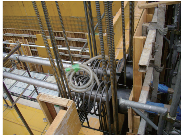
写真 - 7 PC 鋼線配線
