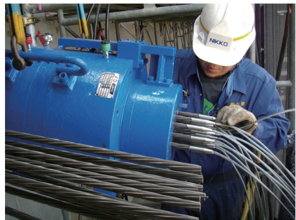
写真 - 9 緊張工事の様子
