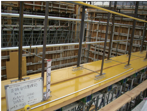
写真 - 4 PC 鋼線用仮設架台
