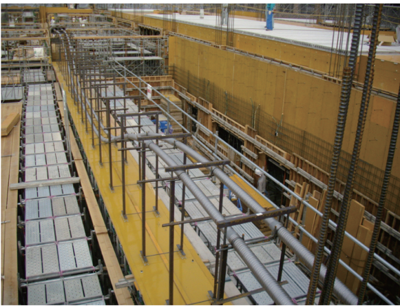
写真 - 5 PC 鋼線用シース管配置
