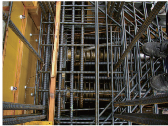
写真 - 8 配筋後の様子
