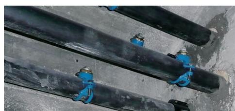
写真 - 9 イッシー橋の外ケーブル排気孔
