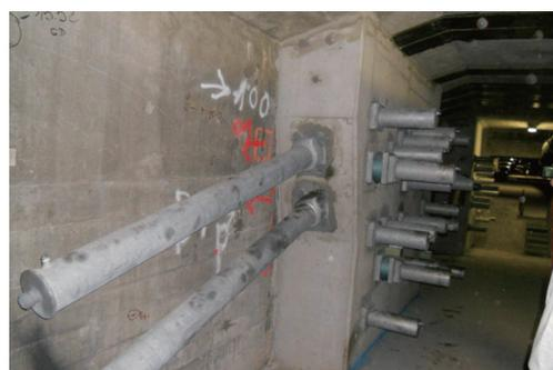
写真 - 10 イッシー橋の外ケーブル定着部
