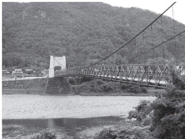
写真 - 6 美濃橋全景
