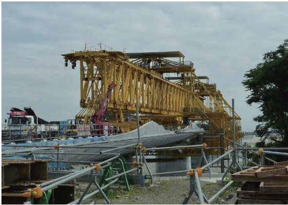
写真 - 2 移動仮設桁 (P&Z工法)
