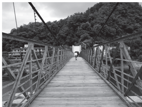
写真 - 9 鉄骨トラスと木製床版
