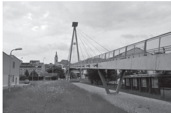
写真-10 ウヘルスキー・ブロード歩道橋
