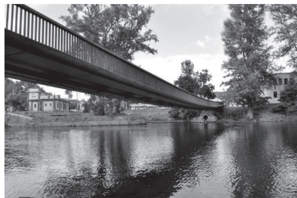
写真-11 ストレス・リボン橋 (DS-L 橋) 全景
