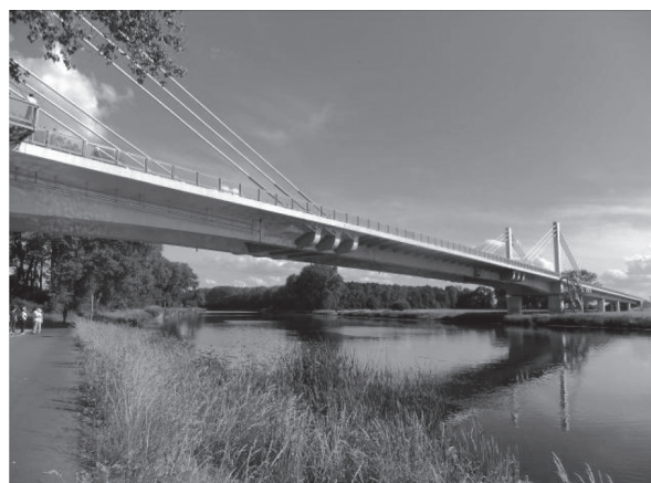
写真 - 13 ニンブルク I 38 道路橋
