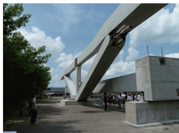
写真 - 4 大型実験橋梁 全景
