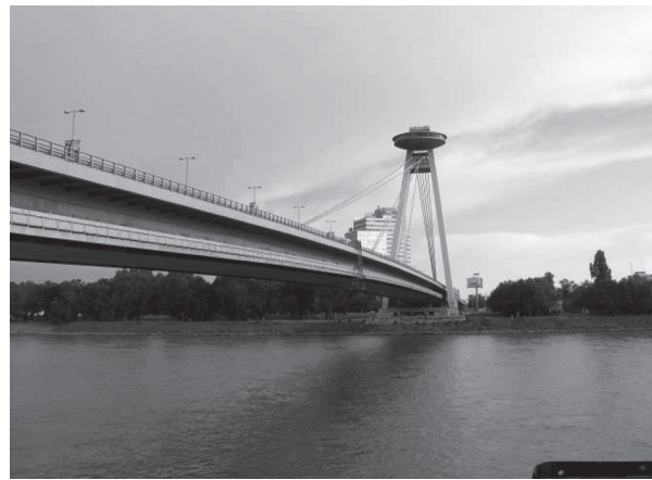
写真 - 5 ブラチスラバ新橋
