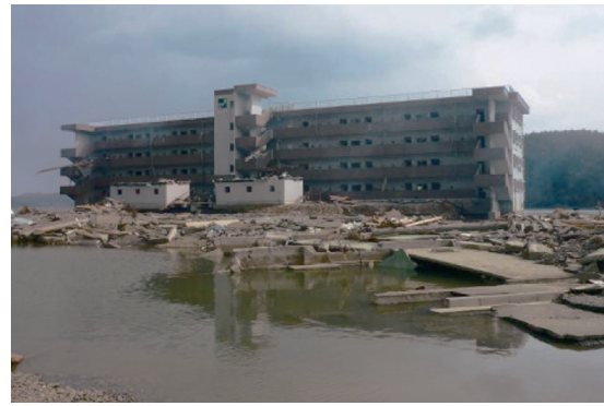
写真 - 13 残存建築物（津波避難ビル）
