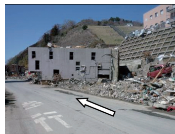
写真 - 9 移動, 転倒した建築物
