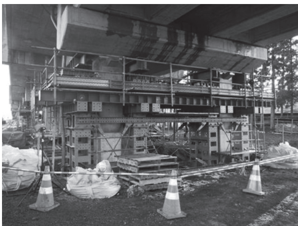
写真 - 2 損傷した RC 橋脚の補修状況
