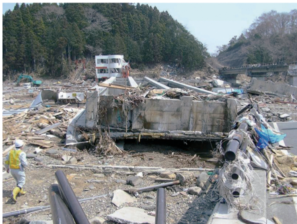
写真 - 6 上下裏返しで落下した主桁
