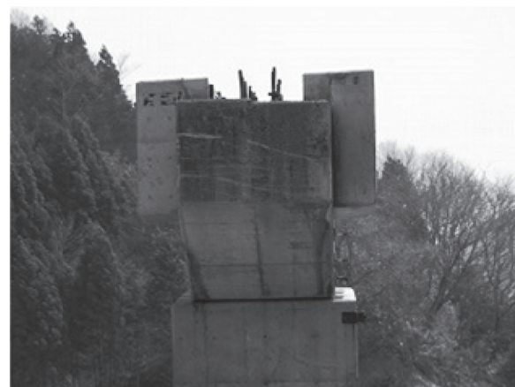
写真 - 5 直立する橋脚天端のアンカーバー
