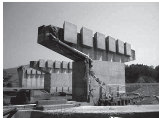
写真 - 4 無損傷の落橋防止装置
