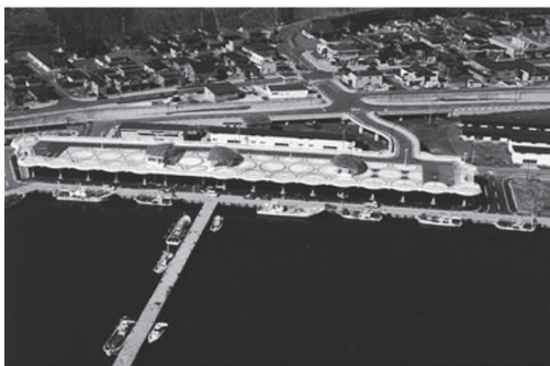
写真 - 4 青苗漁港 (SRC 造)
