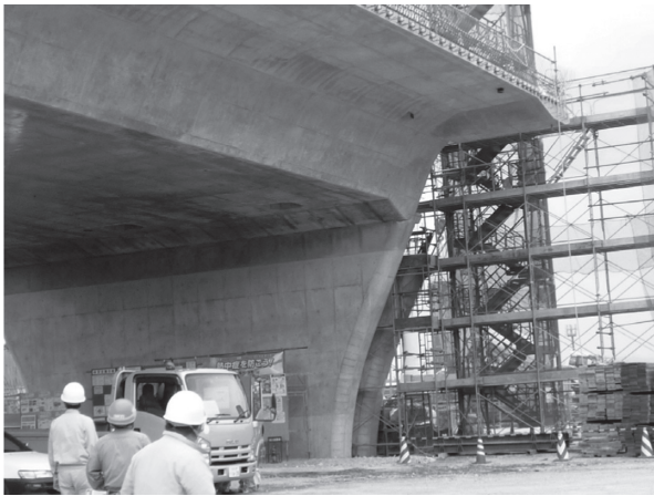
写真 - 1 P 36 - P 39 径間 施工状況
