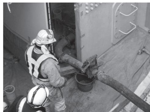
写真 - 3 中詰めコンクリート打設状況
