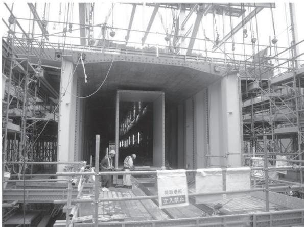
写真 - 4 桁内排気ダクトの架設状況
