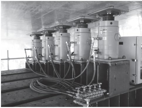
写真 - 2 油圧ジャッキ設置状況
