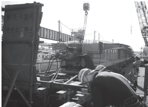
写真 - 6 緊張状況
