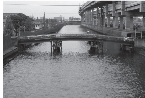
写真 - 2 架替え前の水戸橋
