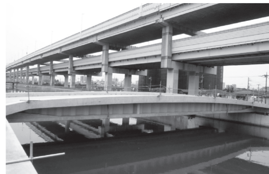
写真 - 9 現況写真
