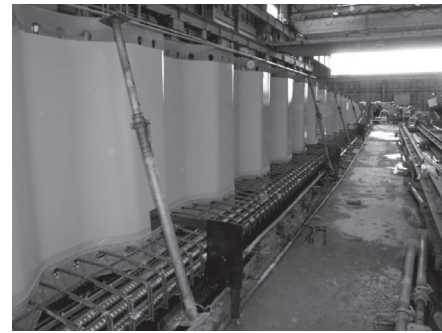
写真 - 4 主桁製作状況
