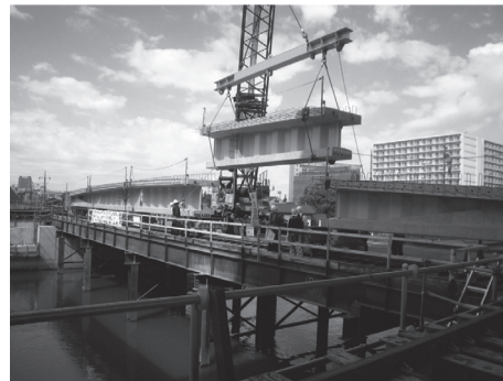
写真 - 5 セグメント搬入状況
