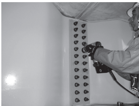
写真 - 7 ボルト接合状況
