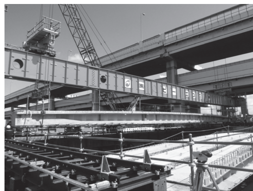
写真 - 8 主桁架設状況
