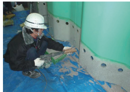
写真 - 3 珪砂塗布状況
