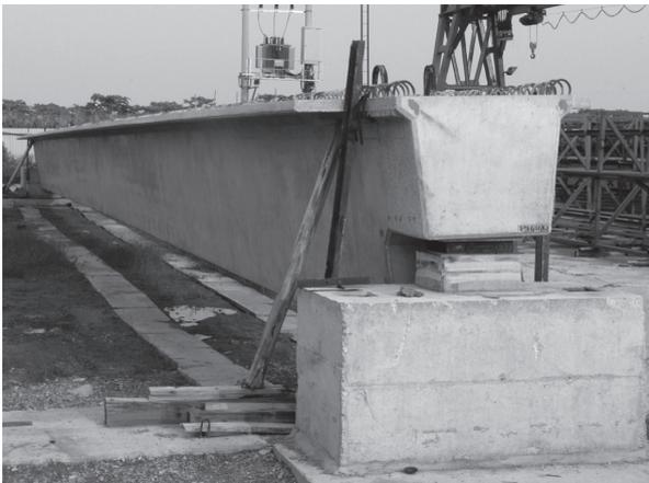
写真 - 5 取付橋用プレテンション方式T桁
