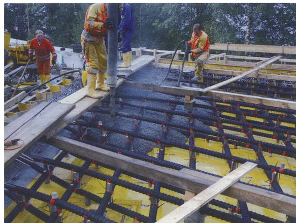
図 - 11 コンクリート打設状況
