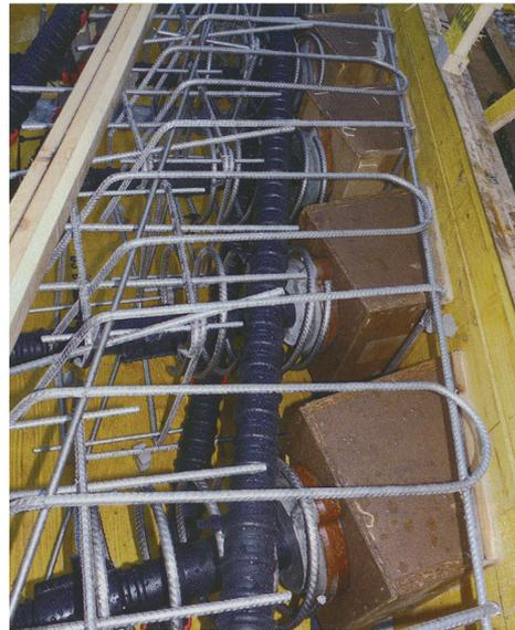
図 - 10 PC定着部補強鉄筋（ステンレス鉄筋）
