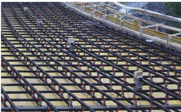
図 - 9 PC鋼材配置状況
