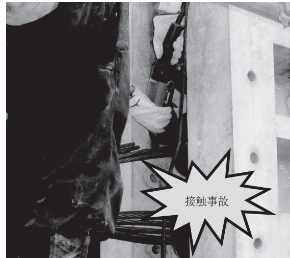
写真 - 8 PC 鋼より線切断時の事故
