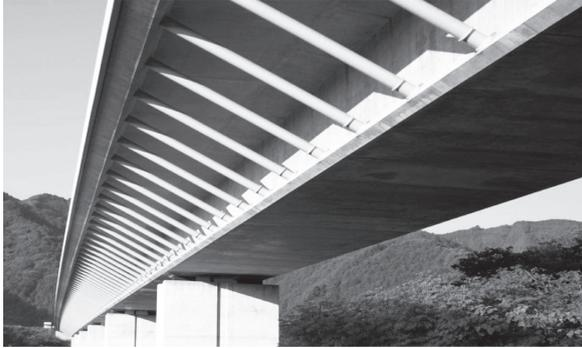
写真 - 1 ストラット付き PC 箱桁 (内牧高架橋)
