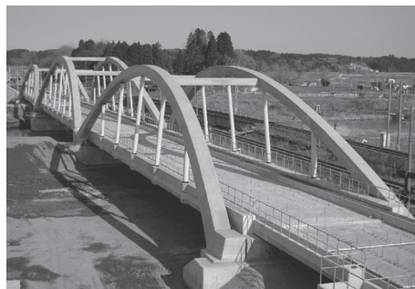
図 - 7 天間川橋梁
