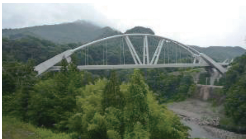
図 - 12 第三吾妻川橋梁
