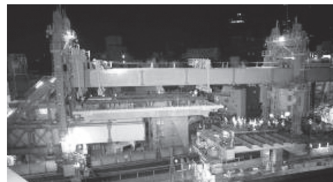
図-5 PC桁架設状況
