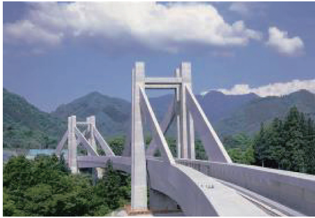
図 - 11 第二吾妻川橋梁
