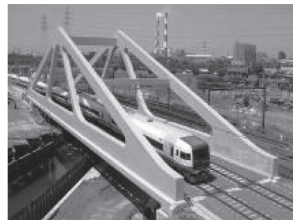
図 - 9 姉ヶ崎橋梁
