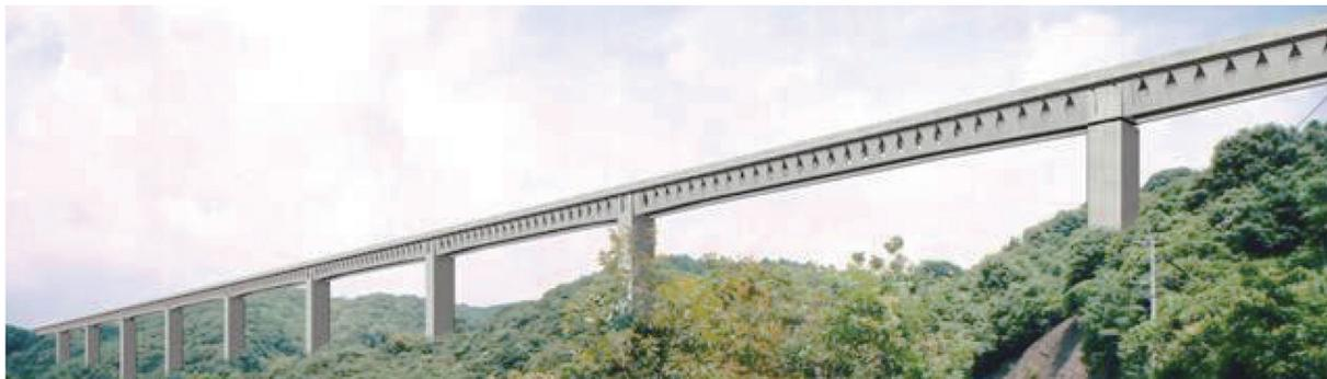
図-3 バタフライウェブを用いた田久保川橋（仮称）完成予想図
