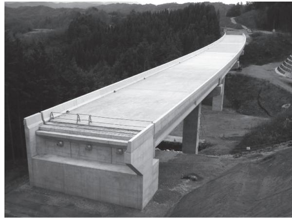
写真 - 3 PC 連結コンポ橋 川尻高架橋 (L = 180 m)
