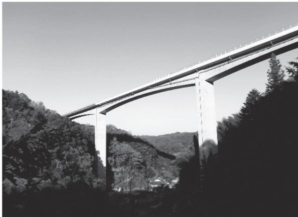
写真 - 2 PC 連続ラーメン箱桁橋
