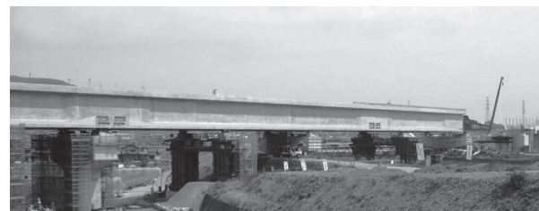
写真 - 1 鳥居川橋梁
