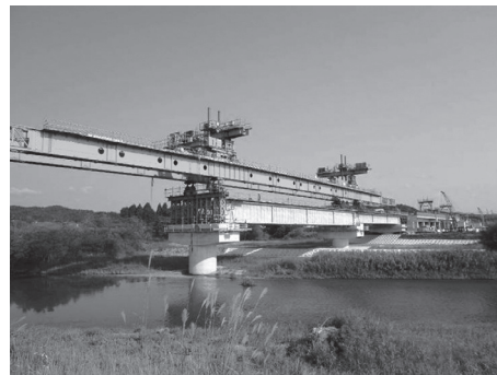
写真 - 5 木古内川橋梁
