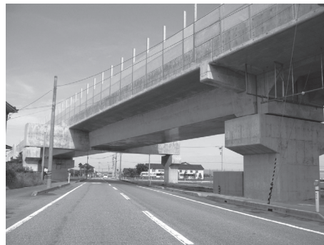
写真 - 4 馬桁一体連続桁(第一安吉架道橋)
