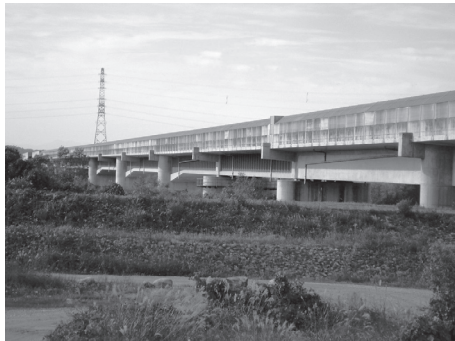
写真 - 2 黒部川橋梁
