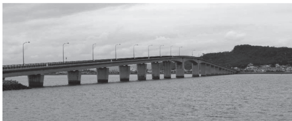
写真-3 浜比嘉大橋全景(平安座島側から望む)
