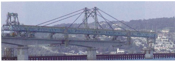
写真 - 6 架設桁による施工状況
