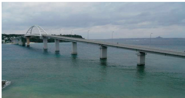
写真 - 1 瀬底大橋全景（本部半島側から望む）
