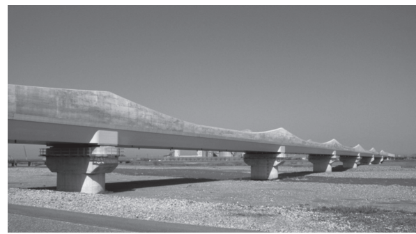
写真 - 2 姫川橋りょう
