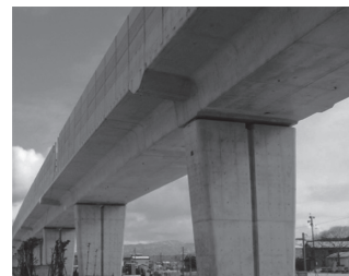
写真 - 3 今村新田高架橋
