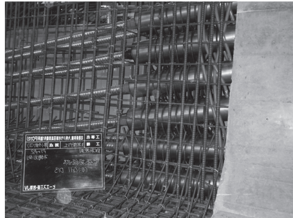
写真 - 5 カップラーによる PC 鋼材接続
