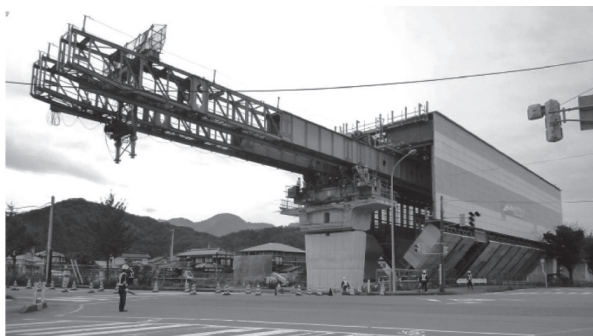
写真 - 4 移動式支保工架設状況
