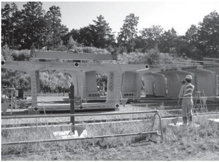
写真 - 5 デジタルカメラによる出来形計測状況
