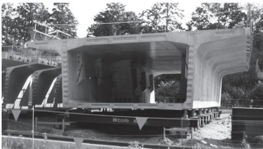
写真-7 ドライマッチによる形状確認
