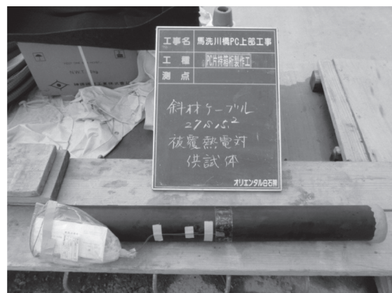
写真 - 11 ダミー斜材による温度計測
