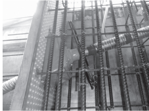
写真 - 13 コーンジョイントおよび支圧板の防錆処理
