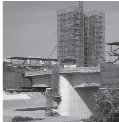
写真 - 17 2段構造の昇降階段
