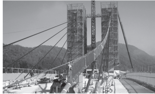
写真 - 10 斜材ケーブル架設状況
