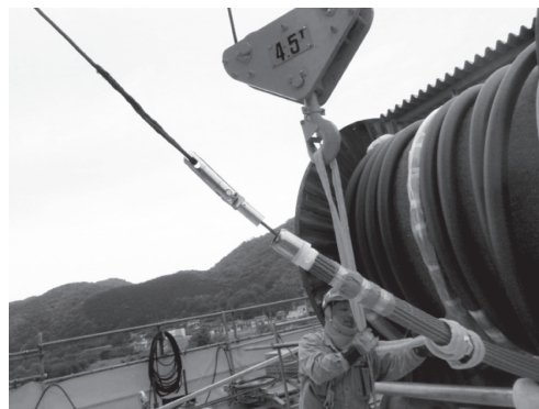
写真 - 8 引出し用金物取付け状況
