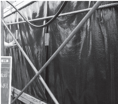
写真 - 6 養生状況 (主塔鉛直面)
