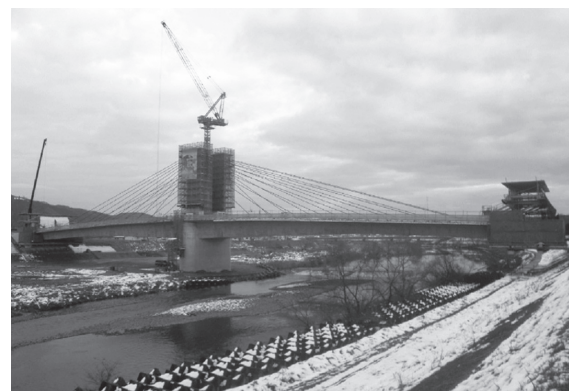
写真 - 18 平成24年1月時点施工全景
