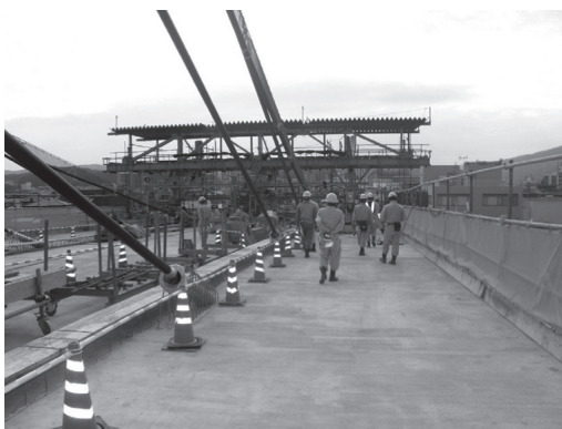
写真 - 16 橋面の使用状況
