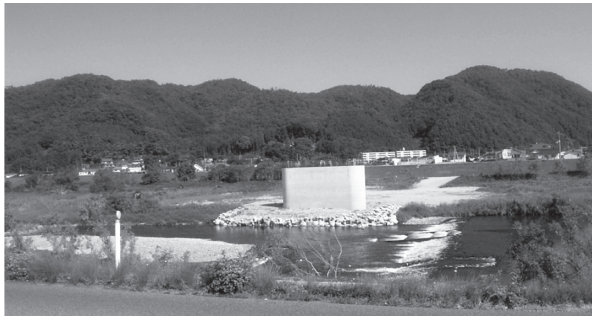
写真 - 2 上部工着手前状況
