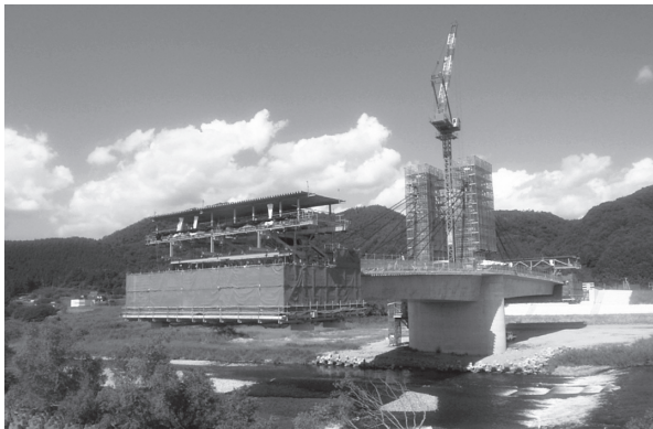
写真 - 3 ワーゲン設置状況
