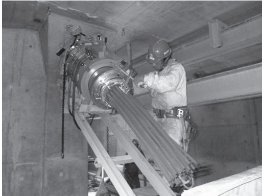
写真 - 12 斜材緊張
