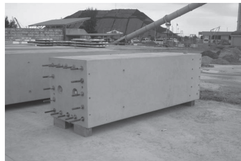
写真 - 7 PCa部材製作完了状況
