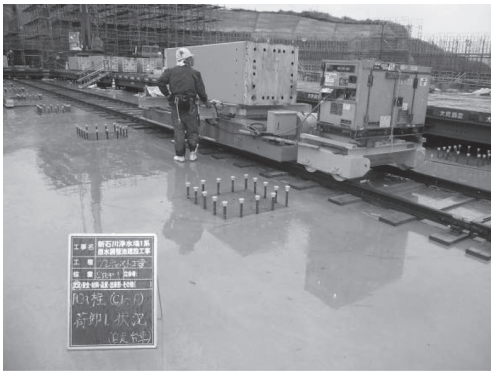
写真 - 8 1系工事 PCa 柱タンク内運搬状況
