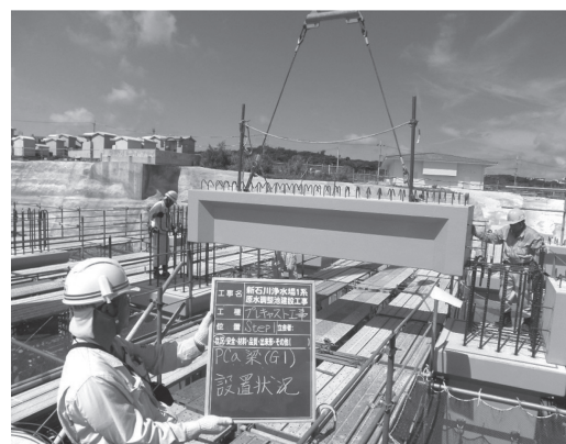
写真 - 12 PCa 梁設置状況
