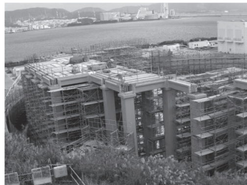
写真 - 11 屋根部材施工状況
