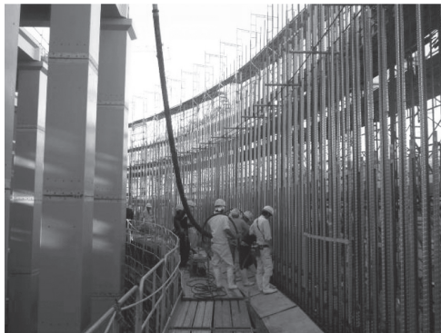
写真 - 6 側壁コンクリート施工状況
