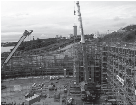
写真 - 9 PCa 柱施工状況
