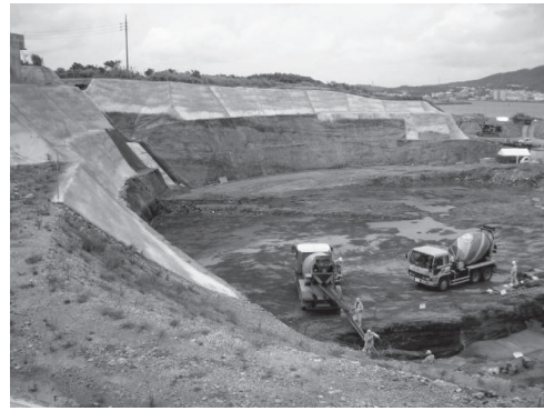
写真 - 2 基礎の置換コンクリート施工状況
