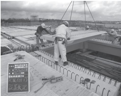
写真 - 13 PCa 製 PC 版設置状況
