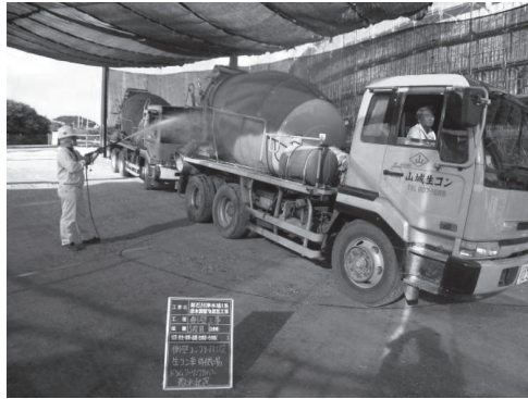
写真 - 5 側壁コンクリートの温度ひび割れ対策
