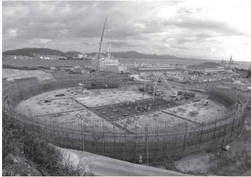
写真 - 3 底版コンクリート施工状況
