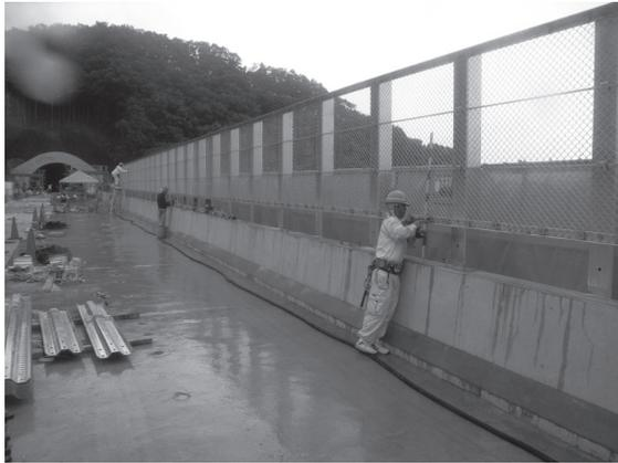
写真 - 9 落下物防止柵設置状況 (F1タイプ)
