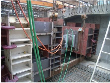
写真 - 6 水平変位調整工実施状況
