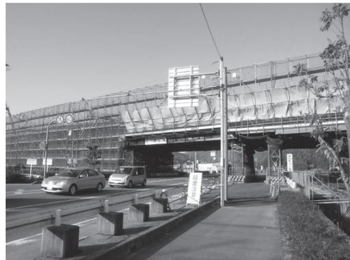
写真-1 3径間部支保工施工(国道312号)
