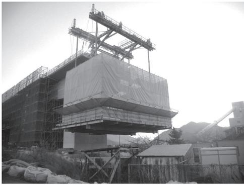
写真 - 2 7 径間部張出し施工 (P4-P5)
