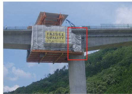
写真 - 7 改造した移動作業車で排水装置設置
