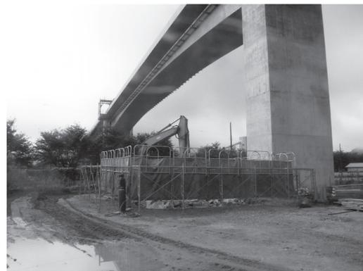
写真 - 4 タワークレーン基礎解体
