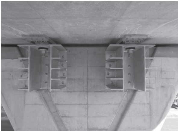
写真 - 11 変位制限装置
