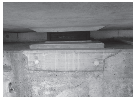
写真 - 10 ゴム支承 再設置完了
