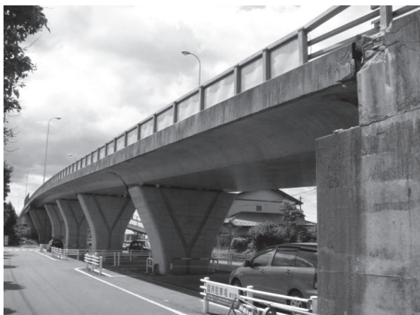
写真 - 1 笠石高架橋全景
