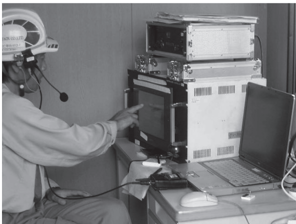
写真 - 7 ジャッキ・ポンプの集中制御
