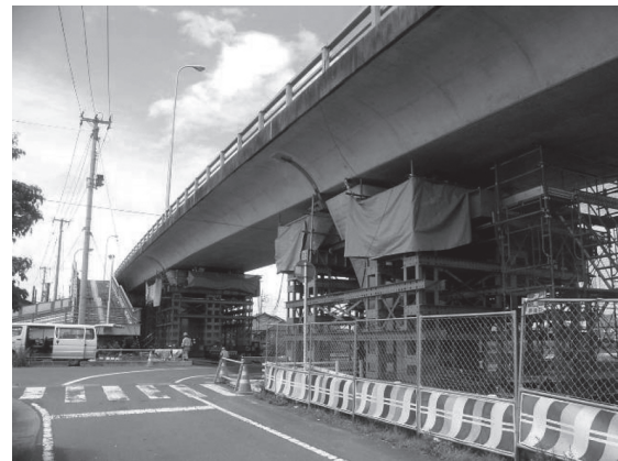
写真 - 5 復旧作業状況
