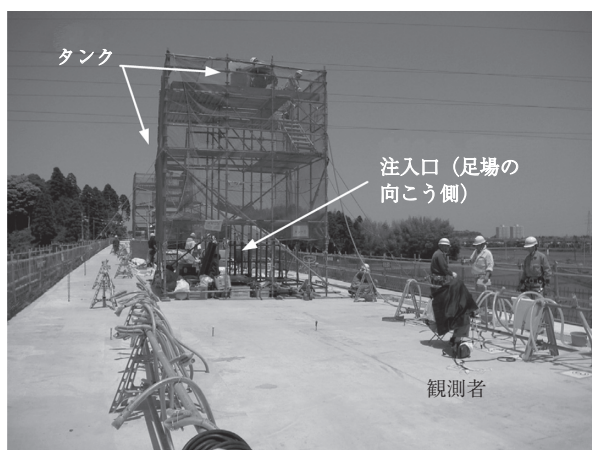
写真 - 6 自然流下方式の施工例
