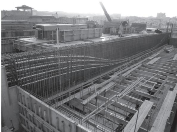
写真 - 1 場所打ち PC 梁の施工状況
