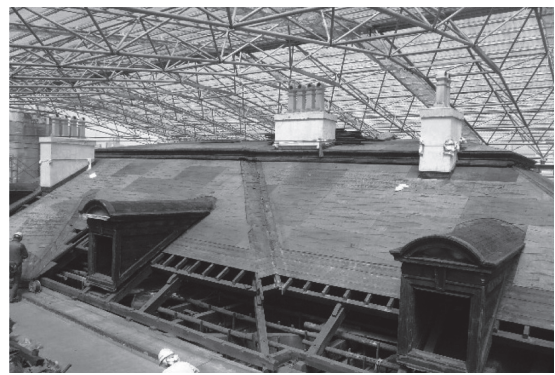
写真 - 5 仮設屋根の下での補強工事
