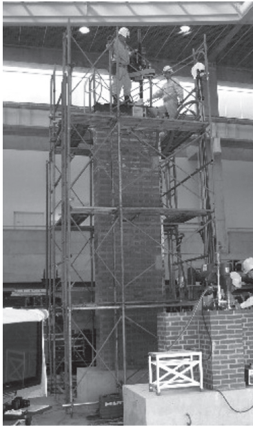
写真 - 11 高さ 5 m モデルでの施工実験
