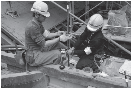
写真 - 8 PC 鋼棒の挿入作業
