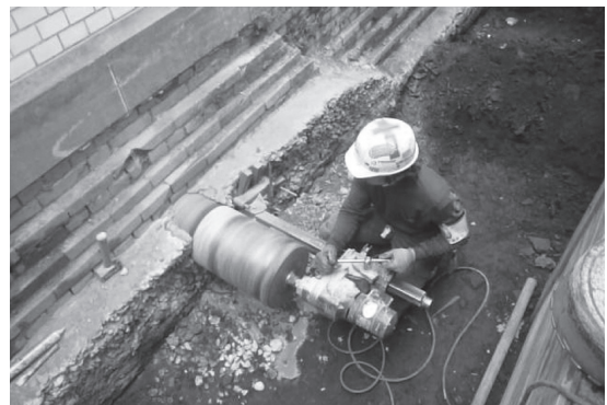
写真 - 7 基礎定着部コア抜き作業
