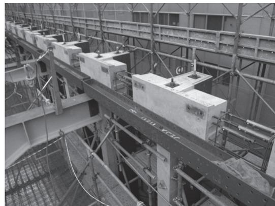
写真 - 8 PC 柱頭部ねじれ防止鋼材取付け状況
