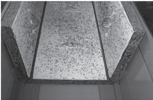
写真 - 2 型枠内石材のセット
