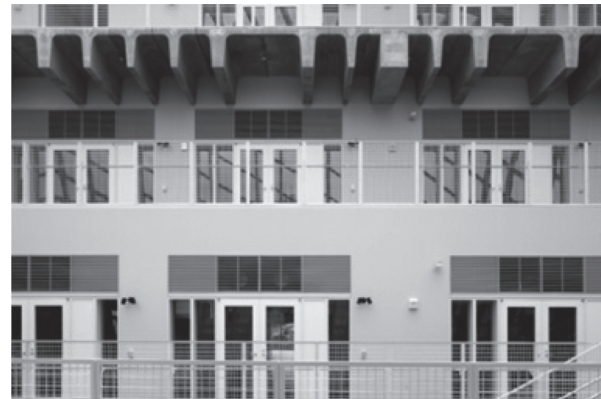
写真 - 4 吹抜け部内観
