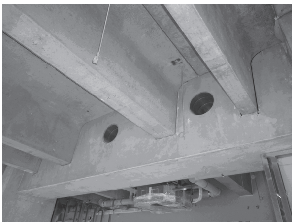
写真 - 6 大梁取り合い部
