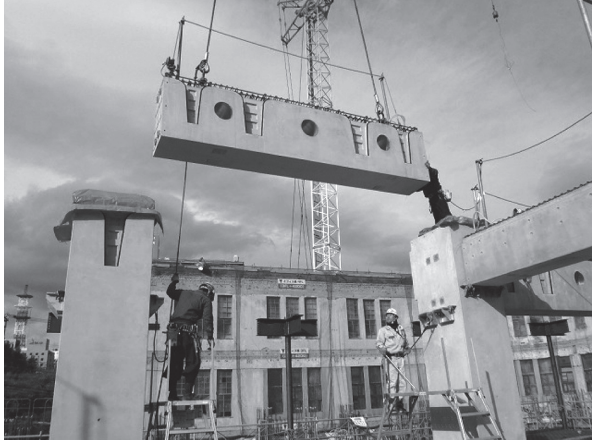
写真 - 9 PC 梁架設状況
