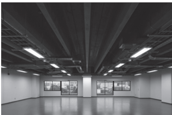
写真 - 3 実験ラボ室上部 PC リブ床版
