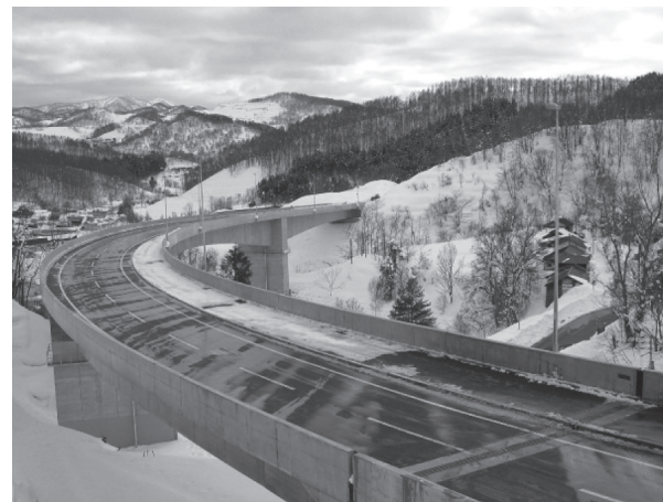
写真 - 5 曲線箱桁橋の事例
