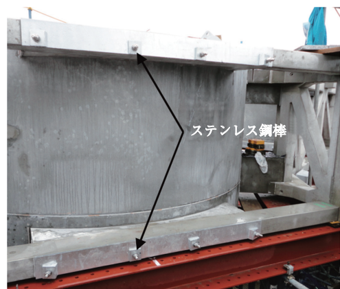
写真 - 1 円筒浮体・連結材接合部
