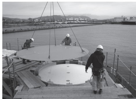
写真 - 10 鋼製天蓋設置状況
