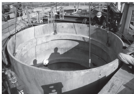
写真 - 4 円筒浮体組立て状況
