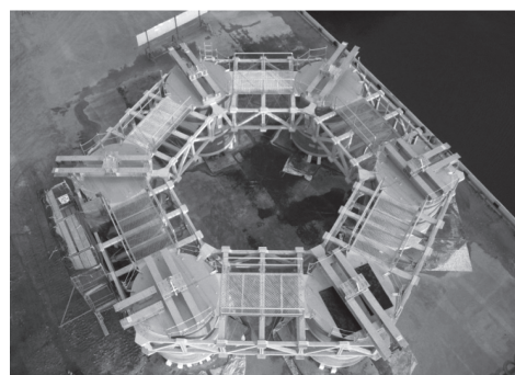
写真 - 11 海上風力発電浮体完成 (上空から)
