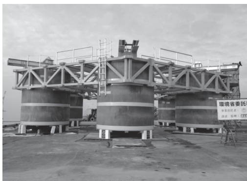
写真-12 海上風力発電浮体完成（側面から）
