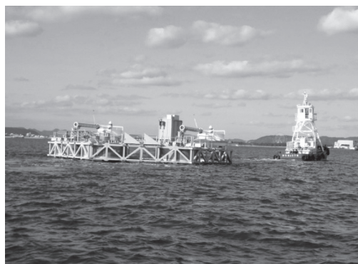
写真-14 曳航状況
