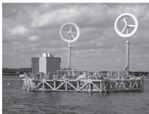
写真-15 風力発電浮体設置完了
