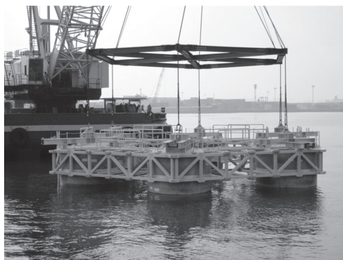
写真-13 浮体進水状況
