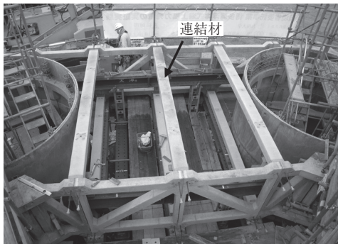
写真 - 8 連結材設置状況
