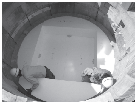
写真 - 9 発泡スチロール設置状況
