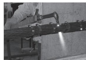
写真 - 12 直接加熱法
