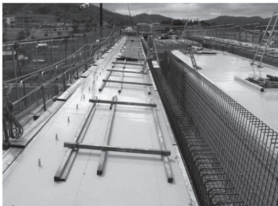
写真 - 2 2 主版桁橋部の型枠と鉄筋の設置状況
